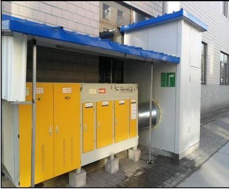
热熔成膜工序废气非甲烷总烃光氧治理措施
